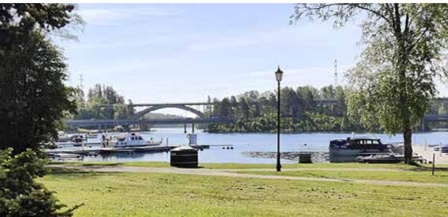
Heinolan rautatiesiltaa rakennettiin lähes neljä vuotta ja nyt sillan avajaisista tulee kuluneeksi 90 vuotta.
