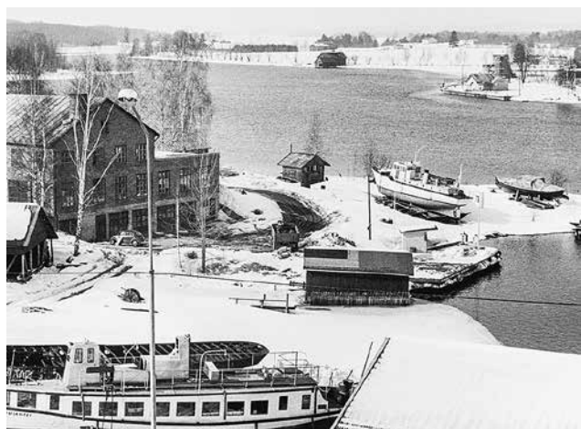
Heinolan Konepajan telakalla kunnostettiin laivoja ja proomuja etenkin talvisin.
